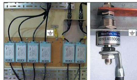
Рис. 2. Фильтры ЭМИ ЯВ с корпусом, выполняющим роль электрода заземления
