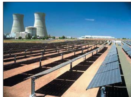
Рис. 8. Фотоэлектрическая электростанция на 2 МВт (вблизи Сакраменто, штат Калифорния)
