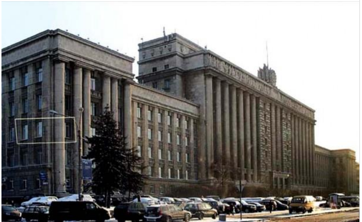
«Дом Советов» на Московском проспекте в Ленинграде (Санкт-Петербурге). Кабинет Ф.Г. Староса – на третьем этаже (два окна обведены рамкой)
